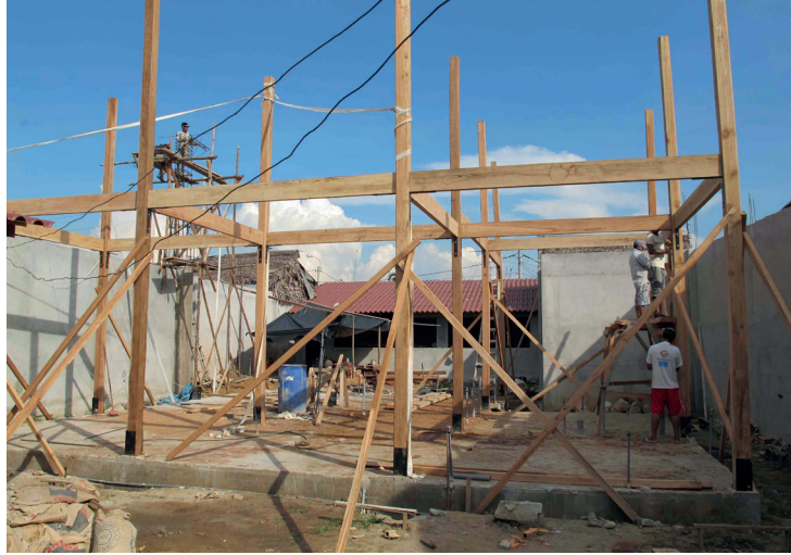
Figura 15. Establecimiento de las columnas, taller en el fondo Fotografía: Guillain Estivals
