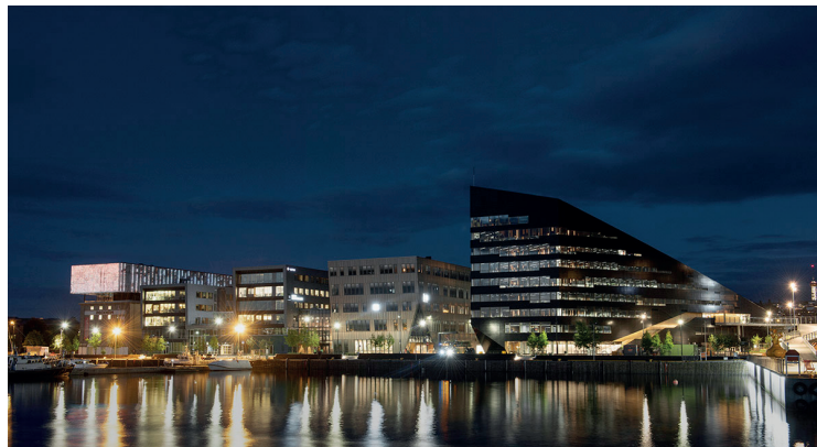
Figura 6. Edificio de oficinas Powerhouse Brattørkaia, Trondheim
