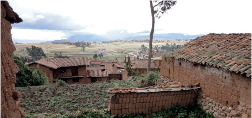
Figura 7. Construcción de tapial, piedra e ichu , Urubamba, Cusco
