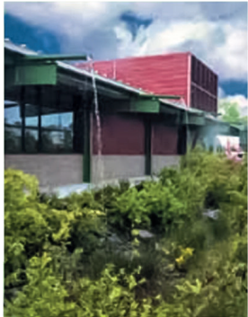
Sistemas de recogida de aguas pluviales. Portland.
