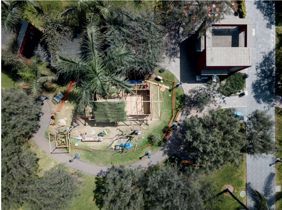
Figura 6. Proceso constructivo del módulo de vivienda
