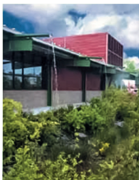
Sistemas de recogida de aguas pluviales. Portland.
