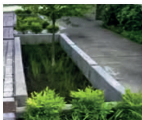
Depósitos de infiltración que actúan como zonas de embalse superficial donde se almacena el agua hasta que se produce la infiltración. Portland.
