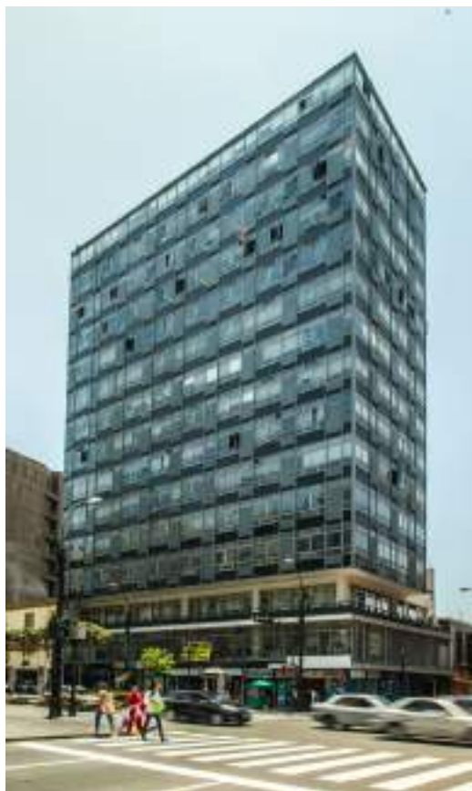
Figura 6. Edificio El Sol Fuente: Fotografía de Martín Fabbri
