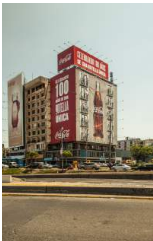
Figura 5. Edificio Nyci Fuente: Fotografía de Martín Fabbri
