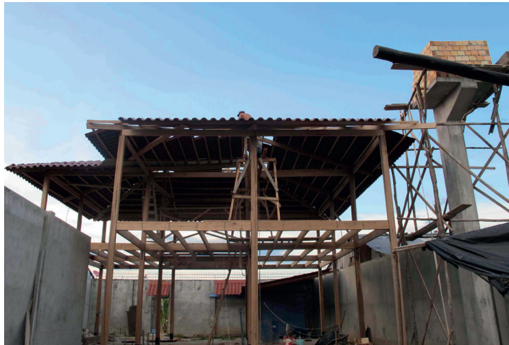
Figura 16. Establecimiento del techo y del tanque elevado Fotografía: Guillain Estivals
