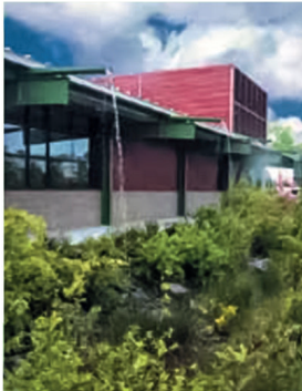
Sistemas de recogida de aguas pluviales. Portland.
