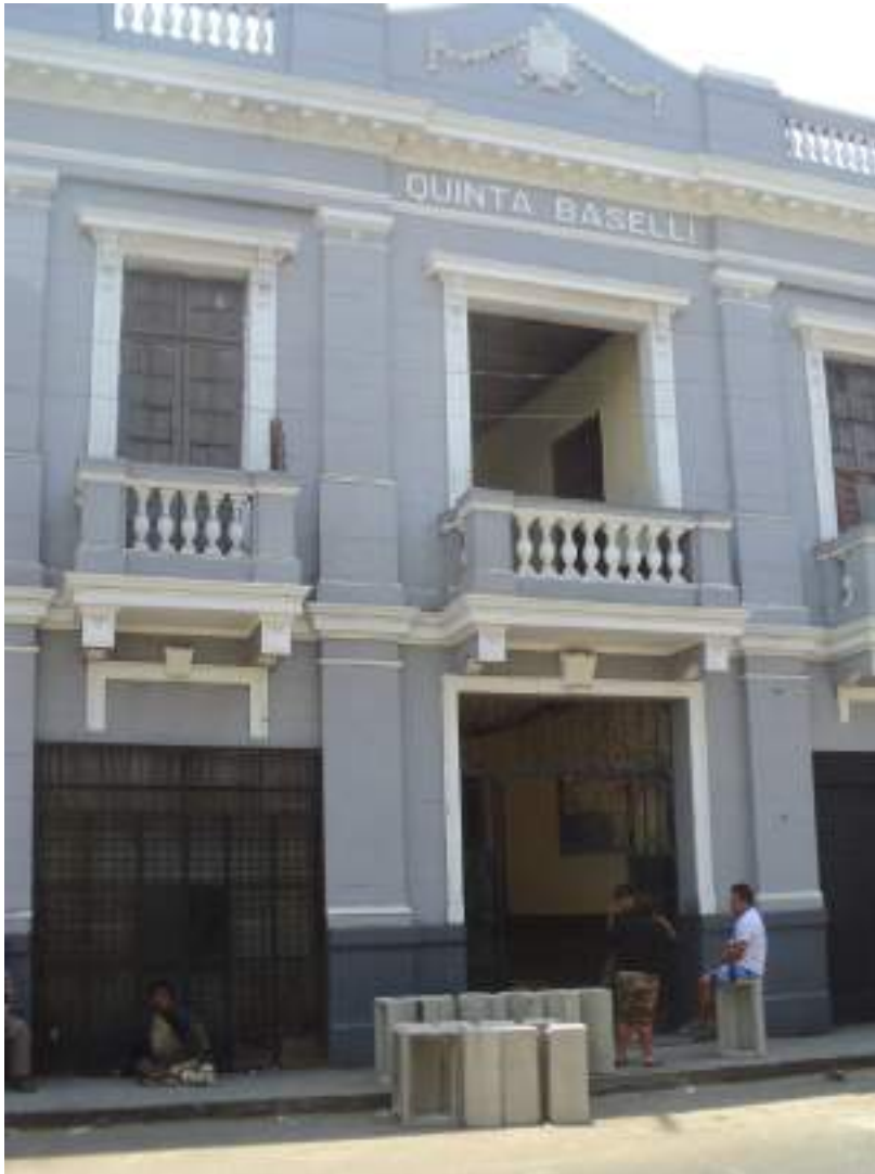
Figura 5 Fachada de la Quinta Baselli
