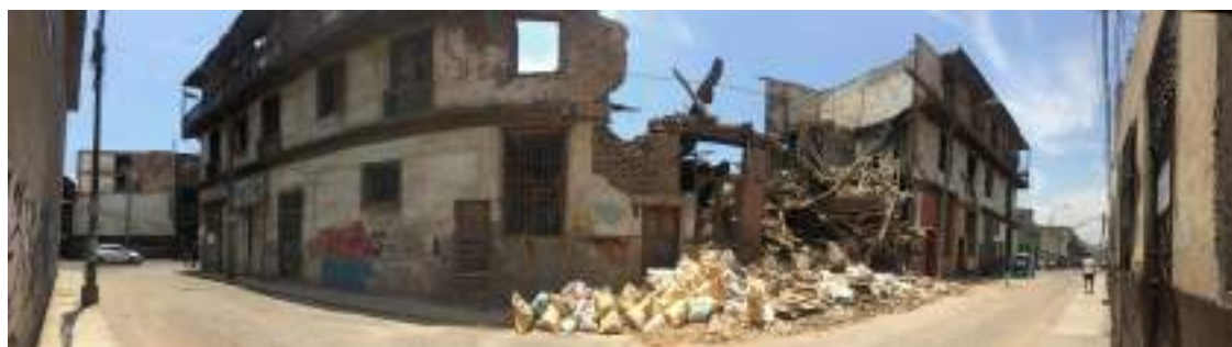
Figura 3 Edificio El Buque visto desde la calle Cangallo
