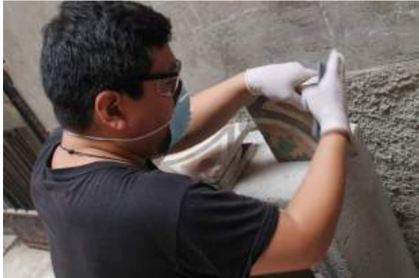
Figura 17 Voluntarios en trabajos de limpieza de las baldosas empastadas originales
