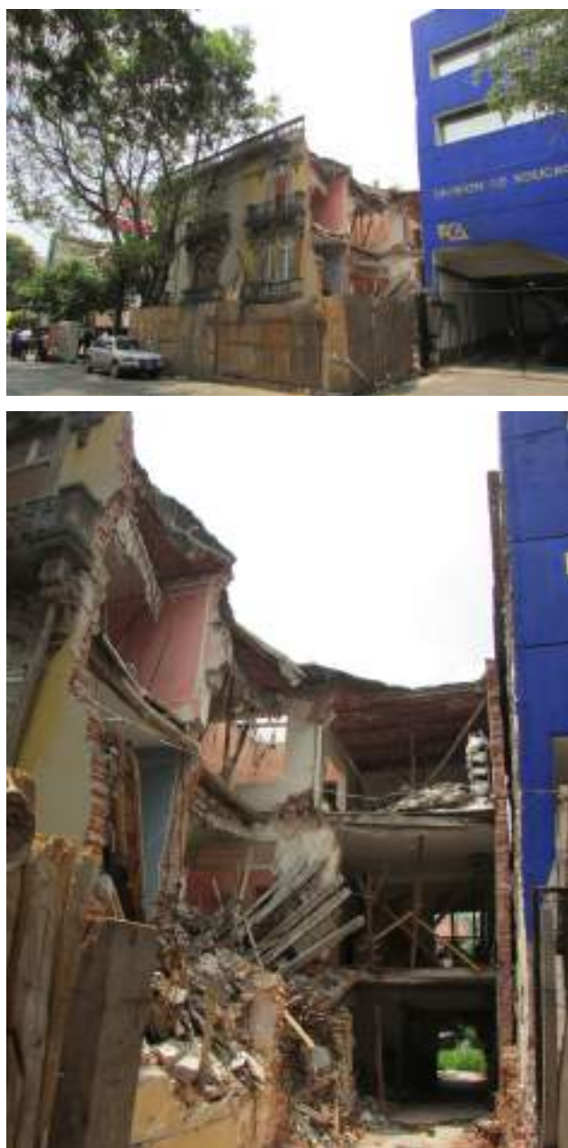
Figura 7 Demolición parcial en calle Liverpool 64 Fotografías: Víctor Delgadillo
