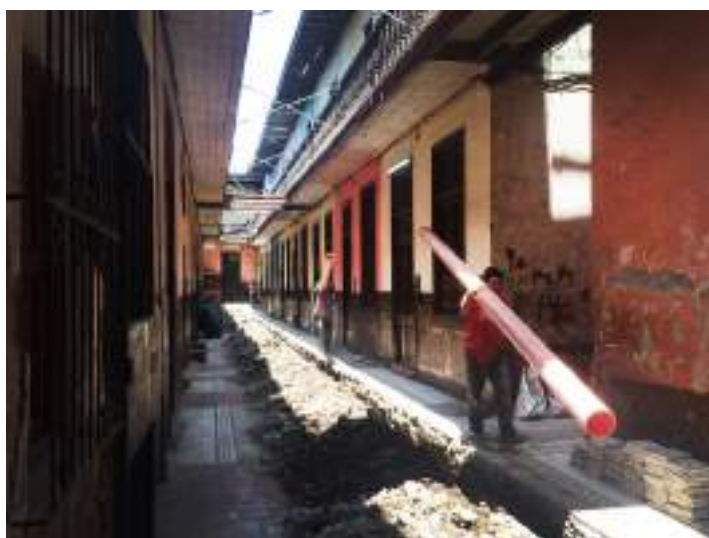
Figura 8 Acarreo de materiales durante la ejecución del proyecto piloto en la Quinta Baselli
