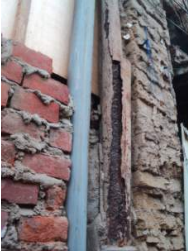
Figura 14 Tuberías de desagüe de PVC y de hierro en la Quinta Baselli
