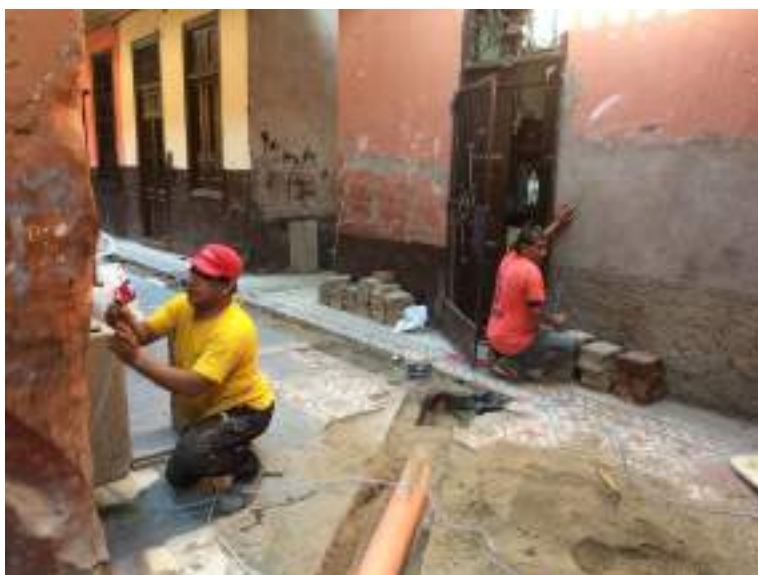
Figura 7 Trabajos durante la ejecución del proyecto piloto en la Quinta Baselli
