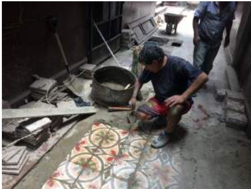
Figura 11 Instalación de baldosas empastadas originales
