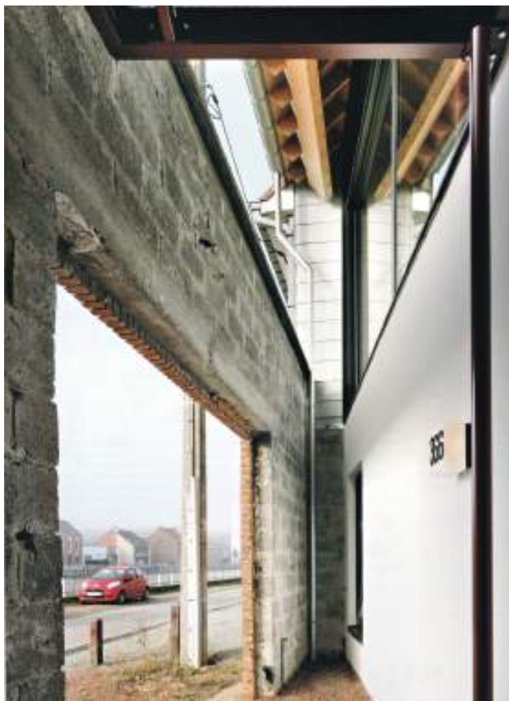
Figura 10. Casa Verbrande Brug, proyecto de De Vylder Vinck Taillieu. Espacio intersticial entre las paredes del antiguo garaje y la fachada de la nueva casa
