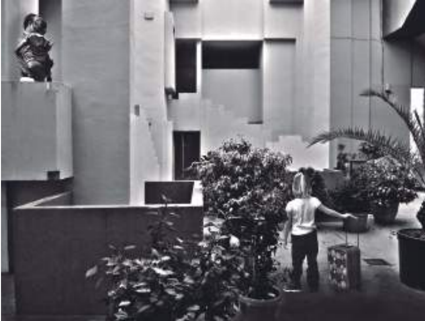
Figura 15 Muralla Roja. Espacios de acceso a las viviendas y terrazas Fuente: Fotografía de Manuel Calleja Molina
