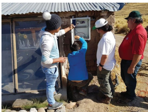
Figura 8. Instalación del sistema de medición de temperatura
