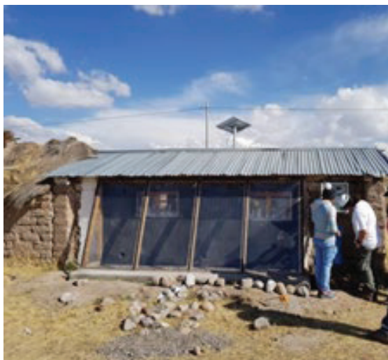
Figura 1. Muro Trombe instalado
