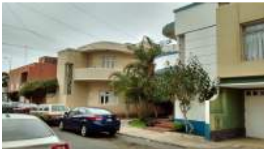
Figura 8 Casa estilo buque, autor desconocido, avenida More, La Punta, Callao, Perú Fotografía: Inés Campos
