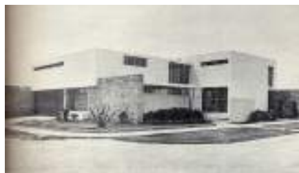
Figura 10 Casa D'Onofrio, de Bianco, Córdova y Williams (1949), demolida, Lima, Perú Fuente: El Arquitecto Peruano , 1950
